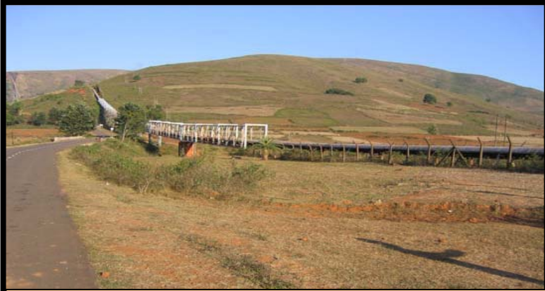
Conveyor Belt of NALCO. Damaniodi
